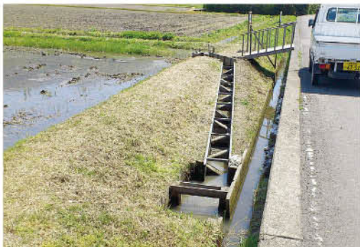
魚が田んぼと水路を行き来できるように作られた水田魚道(若狭町)
