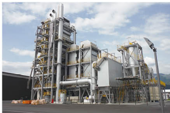
📍 木質バイオマス発電所（大野市）
