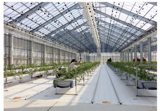
④ 大きなハウスでトマトづくり
