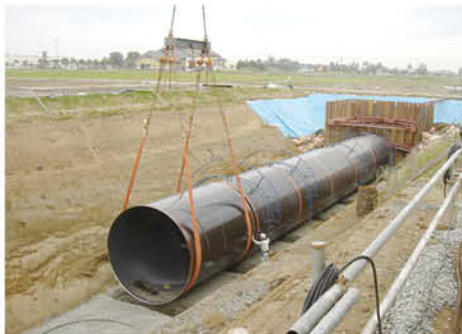
④ 地面を掘って太い管をならべ、つなげる
