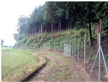
④ 柵の設置
