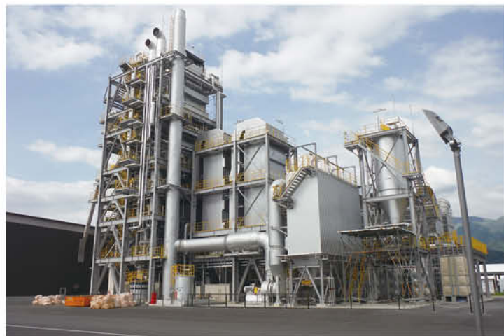
木質バイオマス発電所（大野市）
