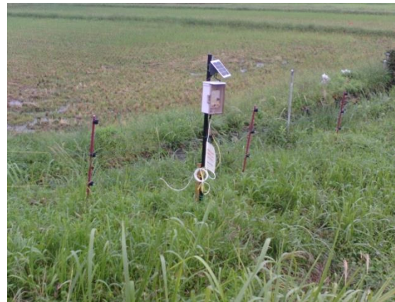
図 2 6 雑草の繁茂により、 電気柵が漏電している
