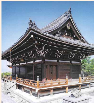
（『国宝 清水寺本堂ほか八棟修理工事報告書 第三集（朝倉堂）』より）
