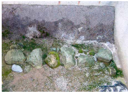
北庄城の石垣 (北の庄城址・柴田公園)
