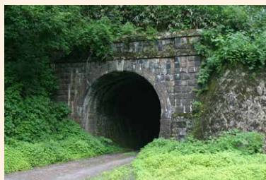
小刀根トンネル（明治14年開通・敦賀市指定文化財）
