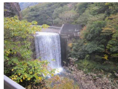
砂防堰堤の一例
