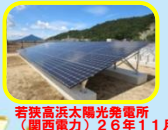
若狭高浜太陽光発電所 (関西電力) 26年11月～
