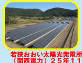
若狭おおい太陽光発電所 (関西電力) 25年11月～
