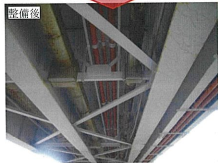
(国道305号(新保橋)の橋梁補修)
