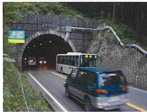
(国道27号 青葉トンネル) ※トンネル断面狭小、トンネル内急カーブ
