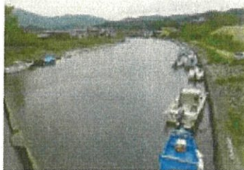
不法係留の状況（井の口川上流）
