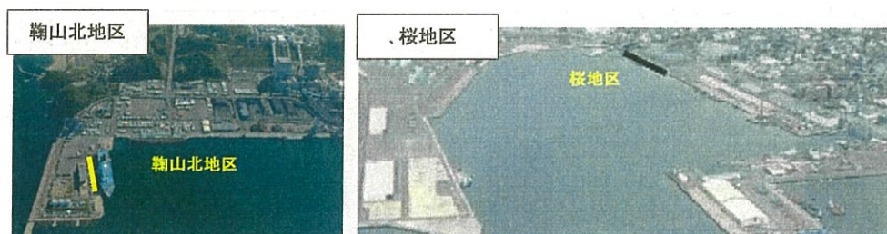
敦賀港における耐震強化岸壁の整備状況
