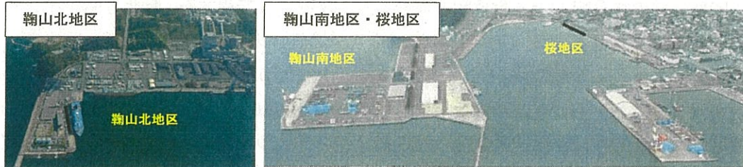
敦賀港における耐震強化岸壁の整備状況
