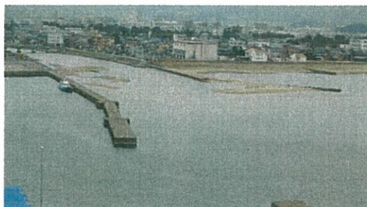
笹の川河口の土砂堆積状況
