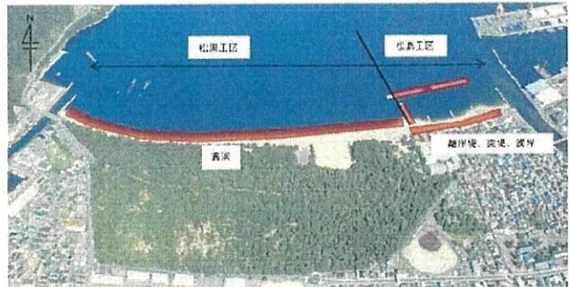
海岸侵食が発生している松原地区では養浜を実施
