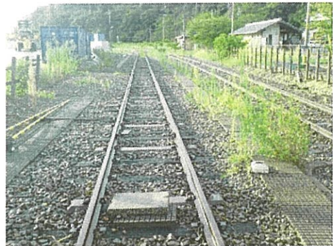
2019 年 4 月で廃止された敦賀港線
