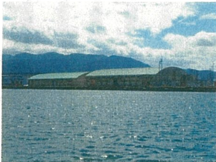
老朽化した倉庫の状況
