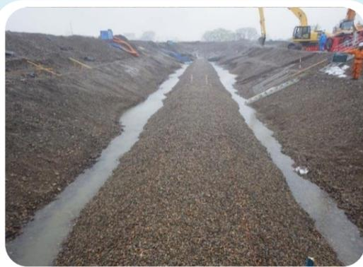
集水埋渠の周囲に、内側から外側へ大砂利、中砂利、小砂利の順にそれぞれ50cm以上充填します。
