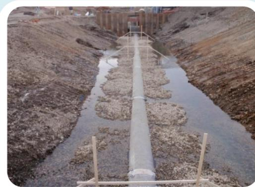
巻線型SUSスクリーン管を継手しながら川底に設置しています。
