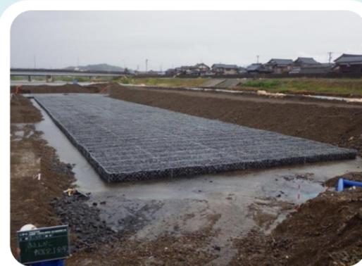
さらに金属製のかごの中に石を並べたふとんかごを設置し、最後に周囲の土砂により河床を整えています。
