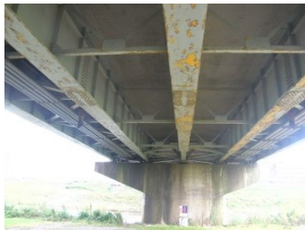
塗装劣化状況（A系塗装10年経過）
