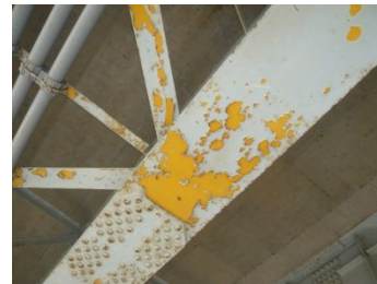
塗装劣化状況（A系塗装10年経過）
