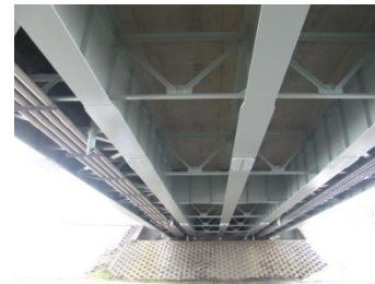
塗装塗り替え完了状況（C系塗装にて長寿命化）
