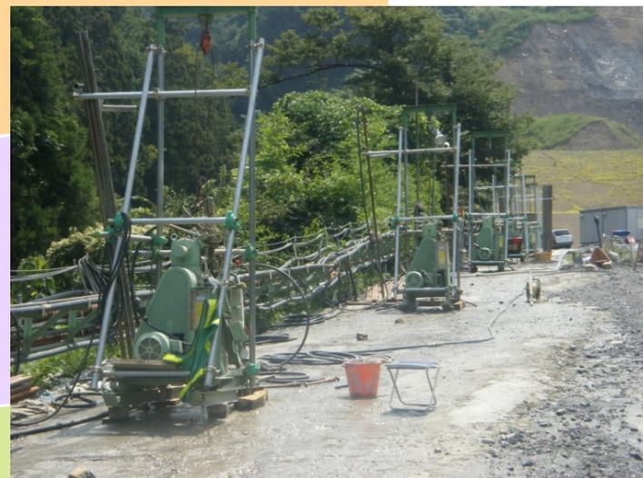
岩盤中の割れ目にモルタルを注入し
