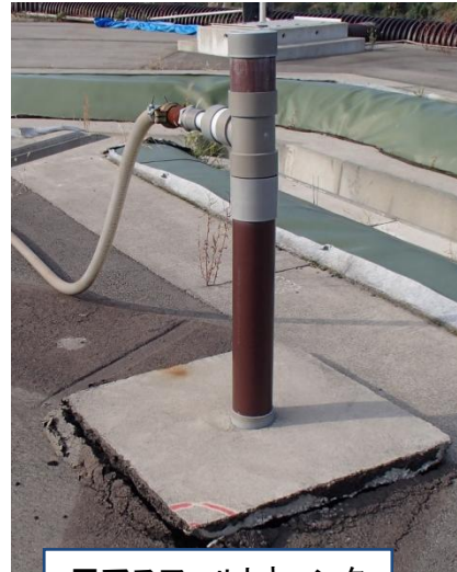
■ アスファルトとコンクリート基礎との隙間
