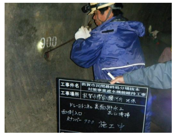
詰まりのみられる裏面排水口を工具などで掘削
