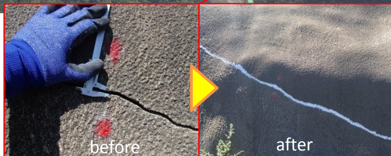
モルタル吹付クラック補修
