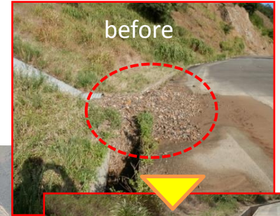
水路堆積土砂除去
