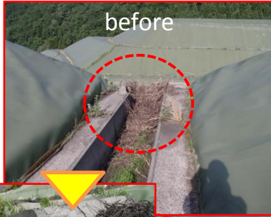
水路堆積塵芥除去
