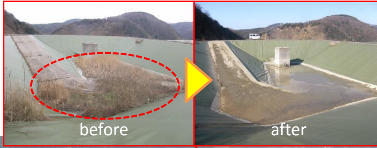
防災調整池堆積物除去
