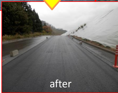
管理用道路の補修
