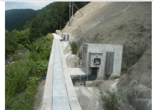
浸出水揚水井戸（上流側）
