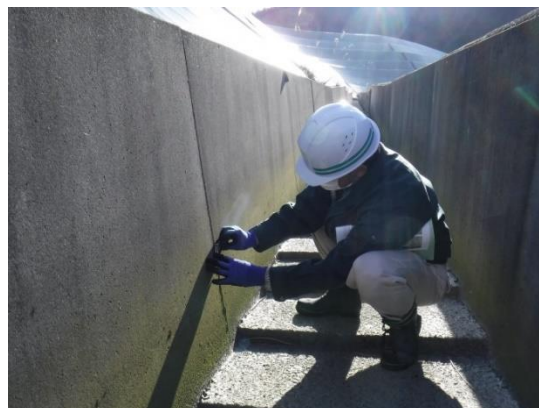
■ 雨水集排水路設備の点検
