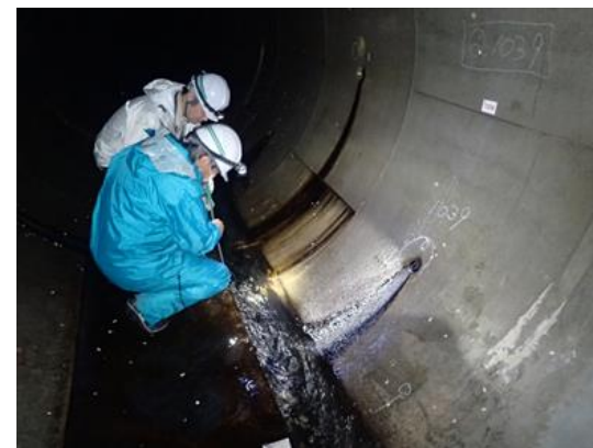
■ ドレーントンネルの点検
