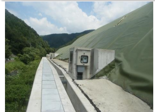
浸出水揚水井戸（下流側）
