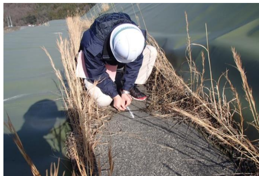
■ 雨水集排水設備の点検
