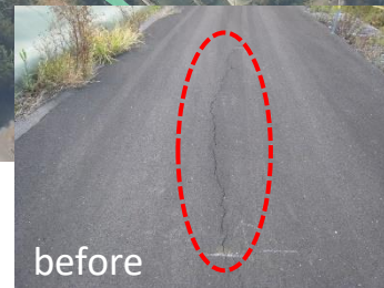
管理用道路ひび割れ補修
