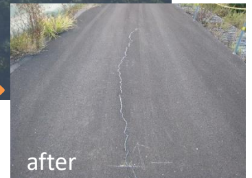
管理用道路ひび割れ補修
