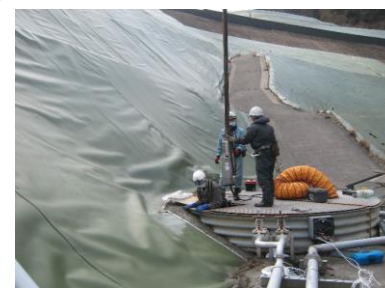
浸出水揚水ポンプ交換状況
