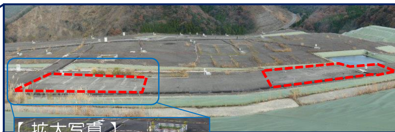
【2021.3 キャッピング撤去エリア】
