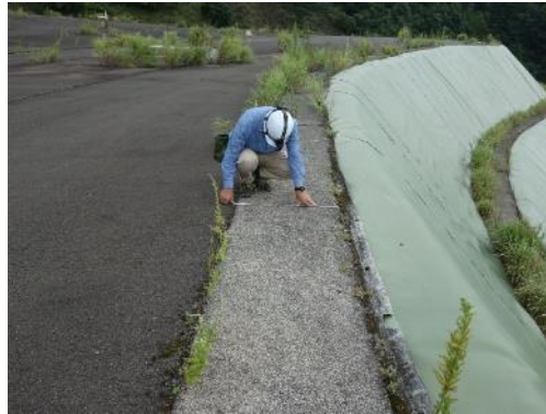
■ 雨水集排水設備の点検
