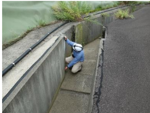
■ 雨水集排水設備の点検
