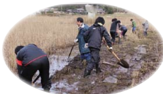
水路の泥上げ作業
