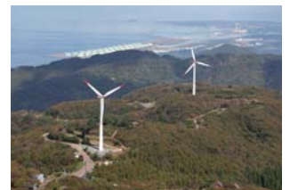
国見岳風力発電所
