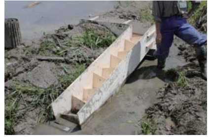
田んぼと小川の間に段差があって魚がのぼれないので、魚用の階段（魚道）をつけたところ 魚は魚道を上って田んぼに入り、卵を産みます
