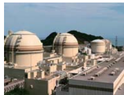
関西電力大飯発電所
