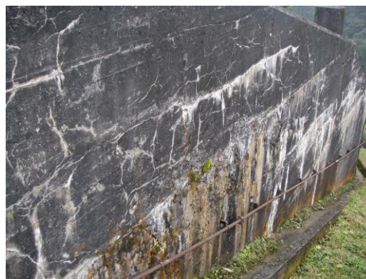
図1-6 ASRが発生した構造物の1例 (水力発電所のアンカーブロック)
