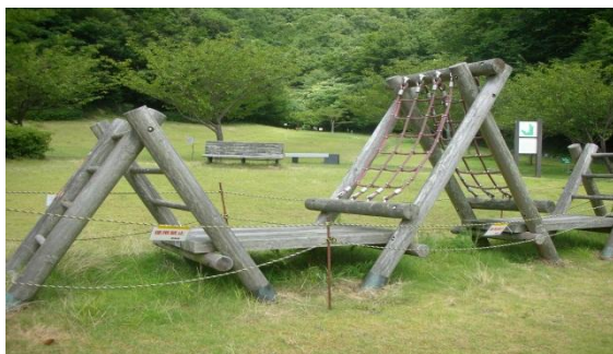
[使用禁止となっている遊具の例1]
