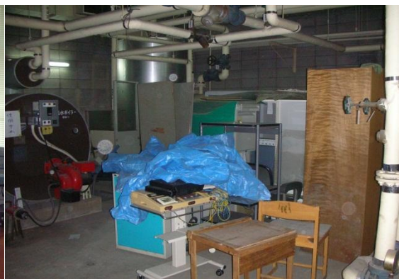
[機械室に備品が置いてあるケース]
