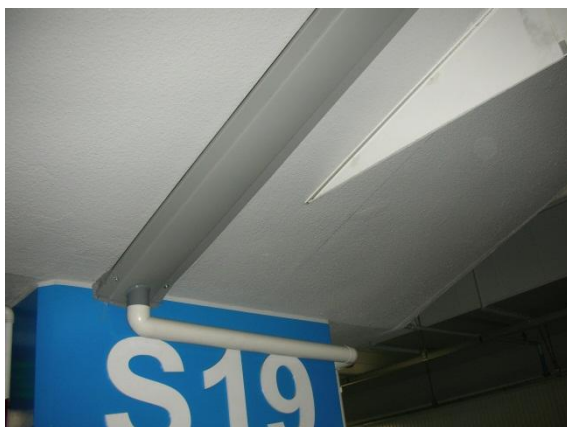
[地下水の浸み出しを修繕した後]
