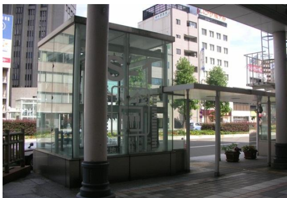
[駐車場への入口]
