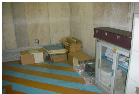
[機械室の状況]
