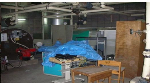
[地下の機械室]
