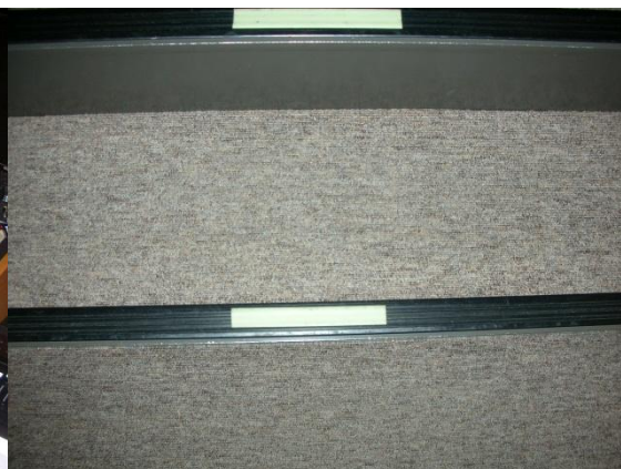
[階段の蓄電テープ]
