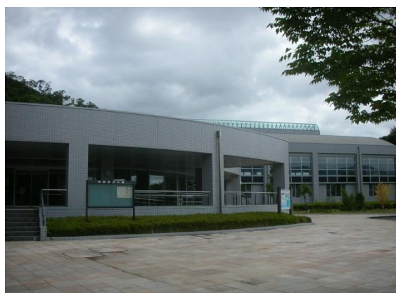
[若狭総合公園・温水プール]
