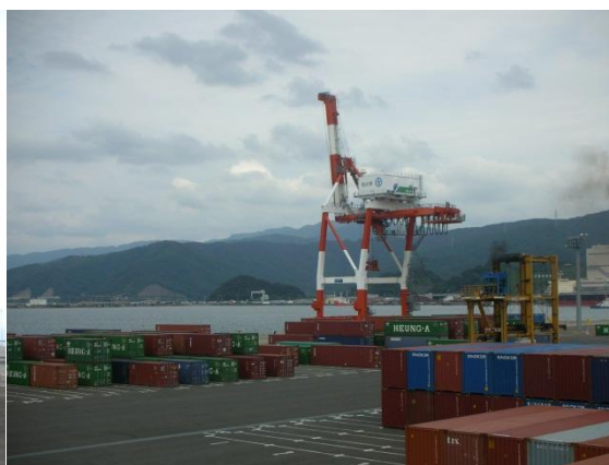
[ガントリークレーン]
