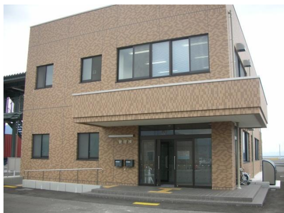
[国際ターミナルの管理棟]
