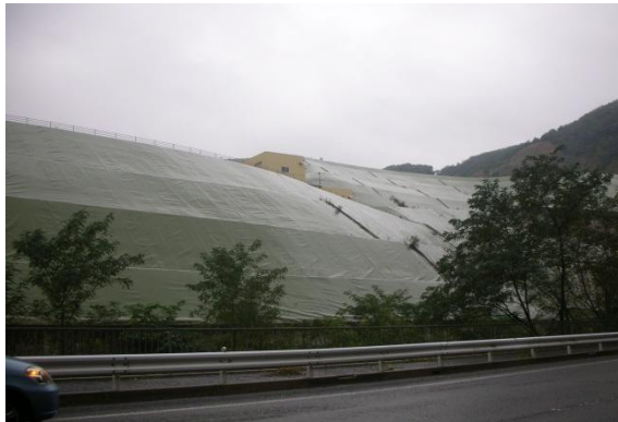
[抜本対策後の処分場外観]
