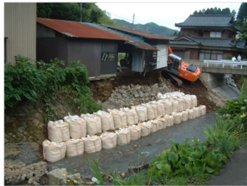
越知川 応急復旧（越前町上糸生）
