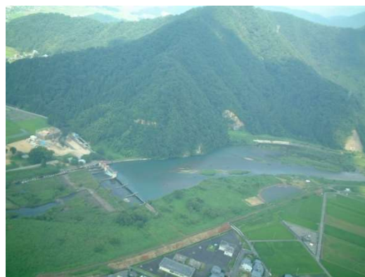
日野川 松ヶ鼻堰（越前市向新保町）
