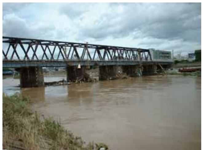
写真-2 福井豪雨後の JR 橋梁のゴミ付着状況
