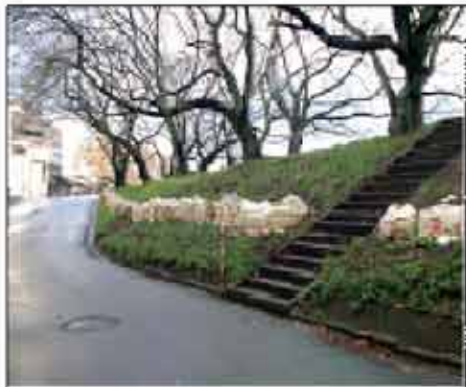
② 勾配変化点での浸食に対する応急対策
