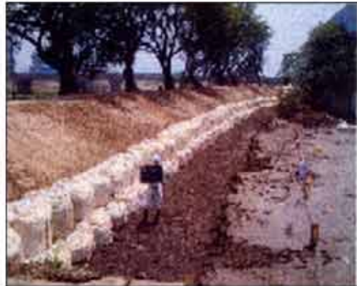
④ 応急対策状況
