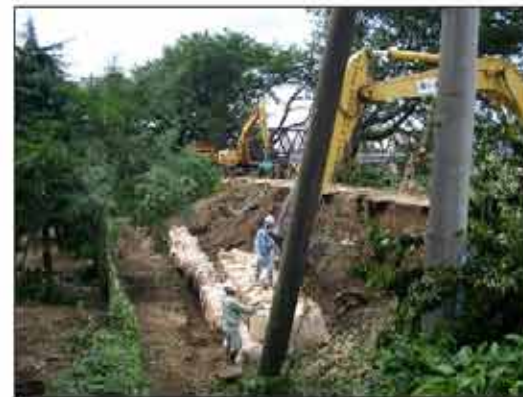
⑥ 裏のり応急対策状況
