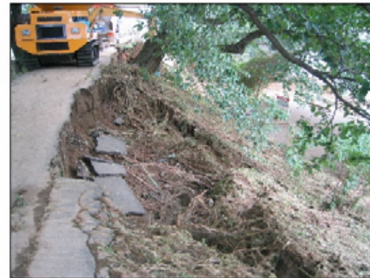
⑤ 裏のり肩被災状況
