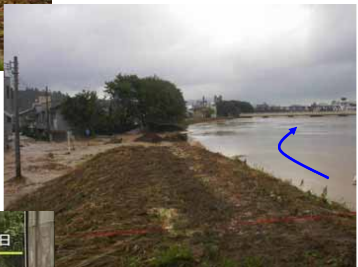
写真 - 破堤部の状況
