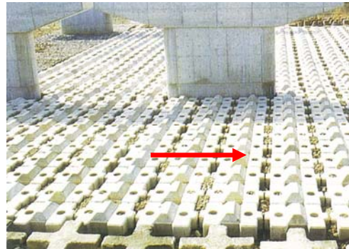
【 橋脚保護工の例(香川県) 】
