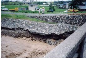
護岸基礎部の洗掘被災状況 (新潟県糸魚川市 姫川) 平成7年7月洪水「梅雨前線」
