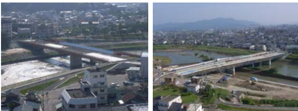
【平成20年7月 工事中】
