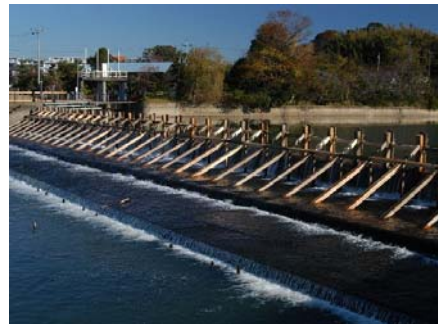
【 千葉県 養老川 西広板羽目堰 】
