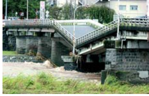
橋脚の洗掘による被災状況 (神奈川県小田原市 酒匂川) 平成19年台風9号
