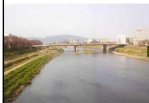
【平成16年11月 着工前】
