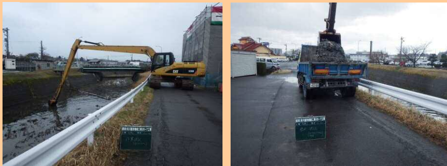
浚渫工事の状況 黒津川（鯖江市 落合町）
