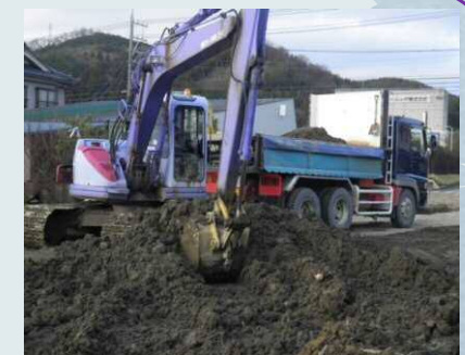
浚渫土砂の搬出・処分
