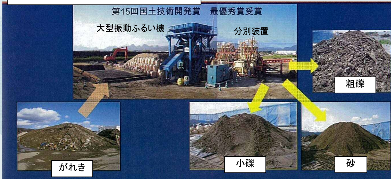
ソイルセパレータ・マルチ工法（東亜建設工業）
