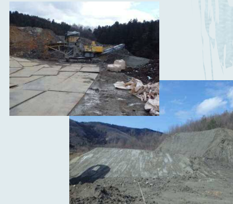
石灰系安定処理
