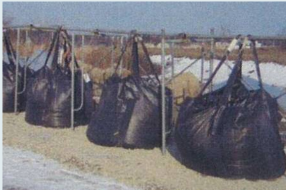
土のうでの脱水
