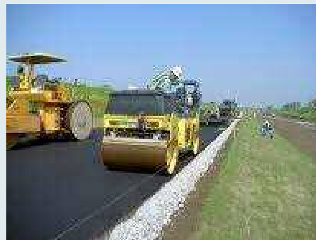
通常の舗装工事
