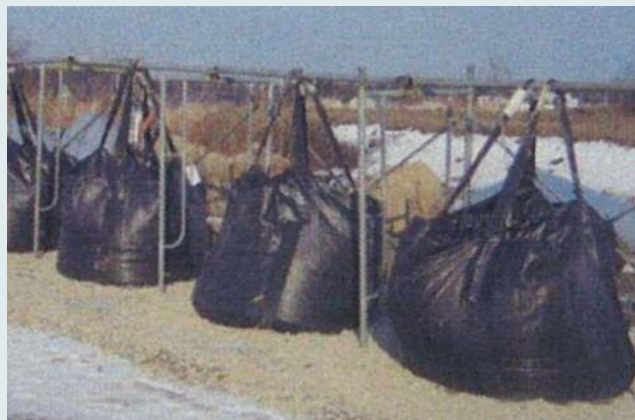
土のうでの脱水
