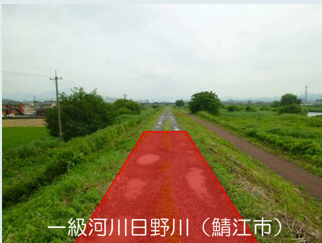
堤防保護(舗装等)への活用
