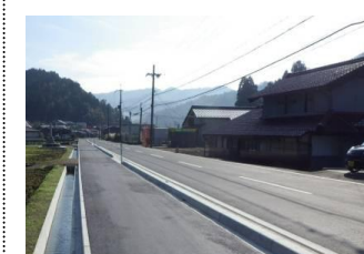
通学路の歩道整備
