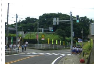
信号機の新設
