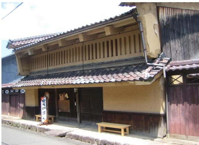
北国街道沿いに建つ京藤甚五郎家。両妻面の壁を屋根面よりも高く持ち上げた本格的な「ウダツ」を上げ、壁面を土壁で塗り籠め、屋根を瓦葺きとするなど、防火を意識した表構えが特徴である。
