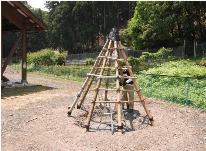
一般社団法人福井県建築士会若狭支部の方々に、秘密基地の骨組を事前に製作してもらった。地面は直径約2m、深さ約20cmほど掘削し、円錐状に竹で骨組を製作。高さは約2.5m。風でとばないように地面に固定した。
