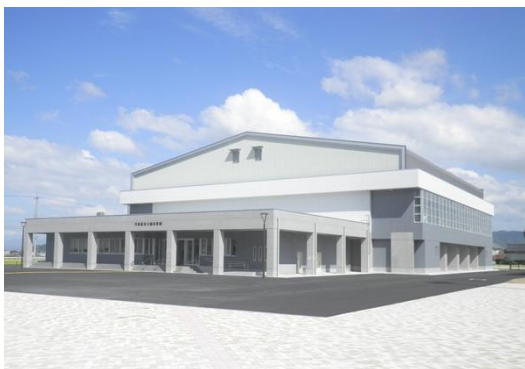
丹南総合公園 体育館建設工事 越前市 平成26年7月竣工
