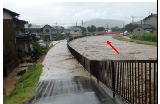
【鞍谷川の越水状況】
