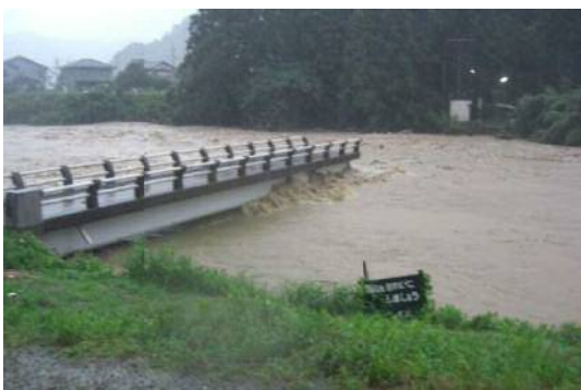
南川の橋梁流出 (小浜市中下井)
