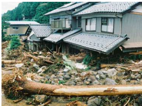
④土石流(鯖江市上河内町)
