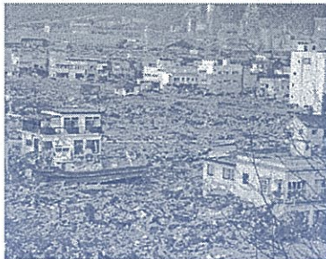
東北地方太平洋沖地震(平成23年)
