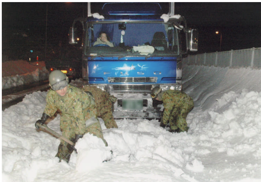
陸上自衛隊の除雪作業(国道8号 敦賀市田結)
