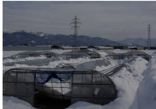
ビニールハウス倒壊(坂井市)
