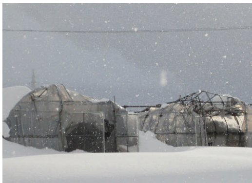
ビニールハウス倒壊(あわら市)
