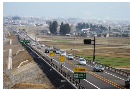
《中部縦貫自動車道大野 I C 付近》
