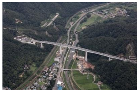
《高さ70mの敦賀衣掛大橋》 (敦賀市)
