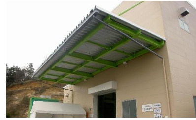
《ふくい WOOD バイオマスセンター》 (あわら市)
