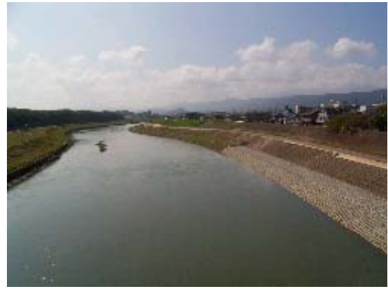
《激甚災害復旧工事が進む足羽川》
