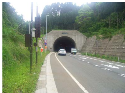
《国道 476 号木ノ芽峠トンネル—南越前町上板取—》
