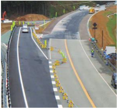
整備が進む永平寺大野道路
