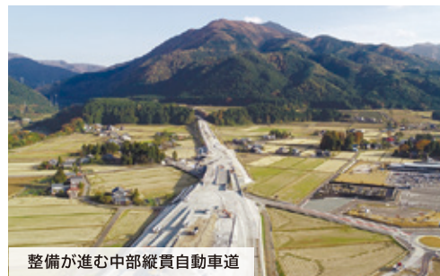
整備が進む中部縦貫自動車道
