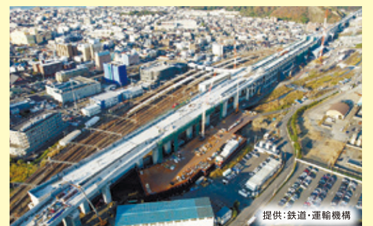
工事が進む北陸新幹線敦賀駅
