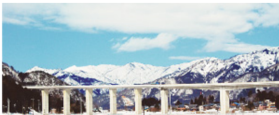
整備が進む中部縦貫自動車道
