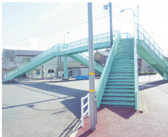
歩道橋の塗装
