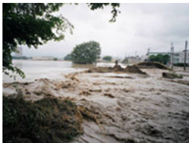
足羽川堤防が破堤(平成16年7月)
