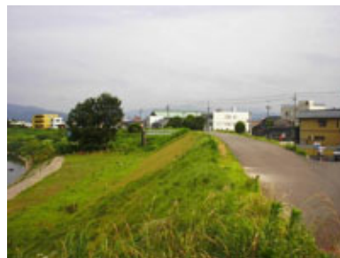
堤防復旧で安全に(現在)
