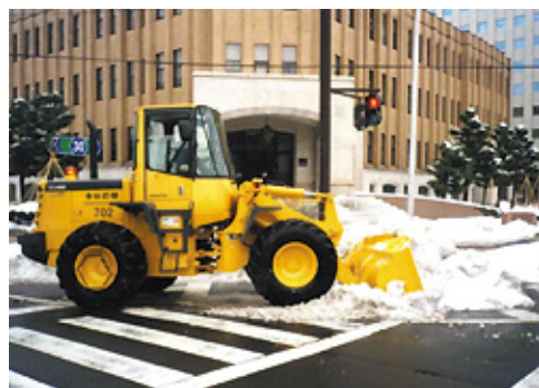
車道の除雪でたまった雪を取り除き、見通しを確保
