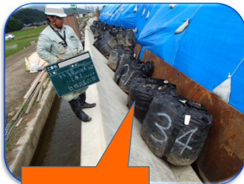
大型土のうで補強
