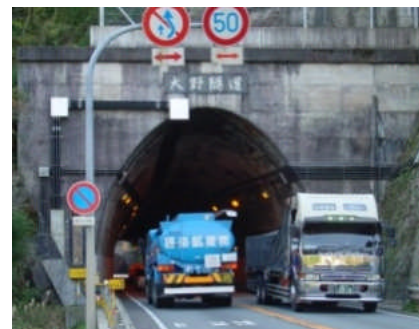
大野トンネル
